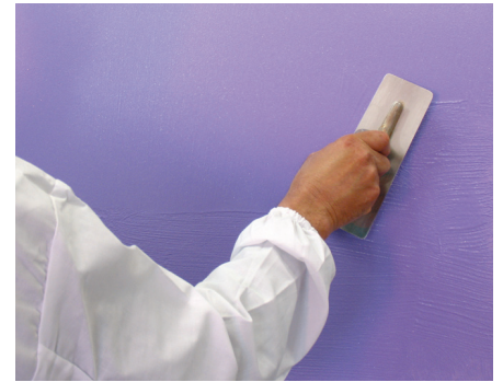
Shine Glätten des ersten Anstrichs
