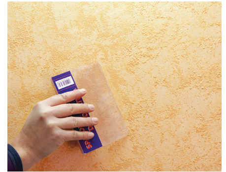
Zweiter Anstrich mit speziellem Doppelklingen-Spachtel Code 1016
