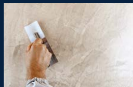
LISCIATURA FINALE final smoothing - lissage final
