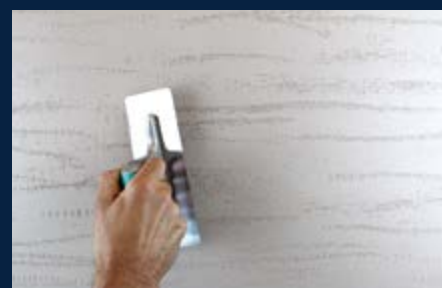
LISCIATURA FINALE final smoothing - lissage final
