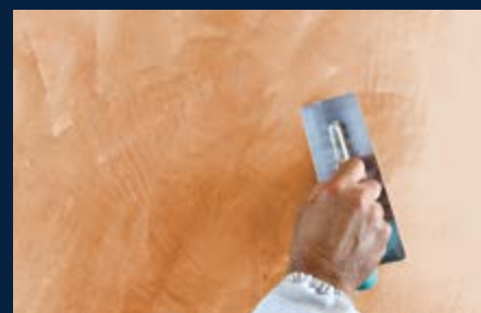
LISCIATURA FINALE final smoothing - lissage final
