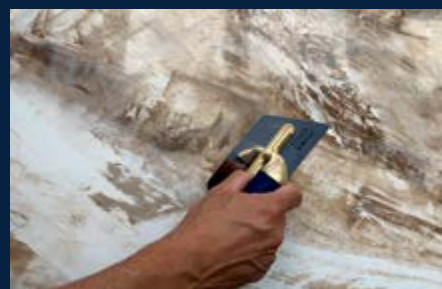
Lisciatura finale final smoothing - lissage final
